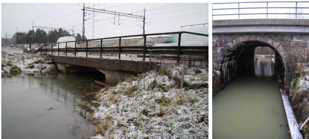
Figur 6. Trähylla och stängsel för väg 859 (tv) och hyllans fortsatta sträckning under järnvägsbron (th). Foto: J Arrendal/MyraNatur.
