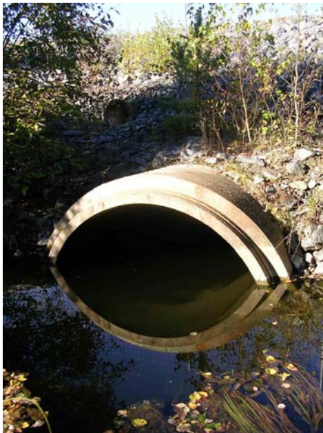
Figur 18. Vattenförande trumma och torrtrumma vid Ledinge. Foto: M Larsson/Vägverket.
