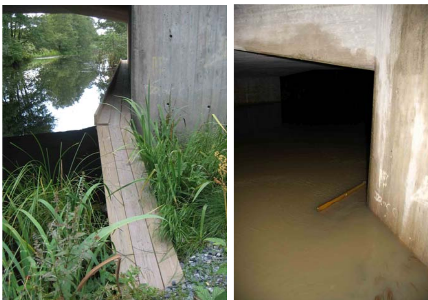
Figur 10. Hyllan vid Brottby (tv). Hyllan i översvämmat tillstånd vid utvärderingen (th). Foto: T Gerenstein/Vägverket (bild tv), J Arrendal/MyraNatur (bild th).
