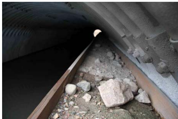
Figur 7. Fylld hylla vid Barkarby (tv) och närbild på hyllans stenfyllning (th). Foto: J Arrendal/MyraNatur.
