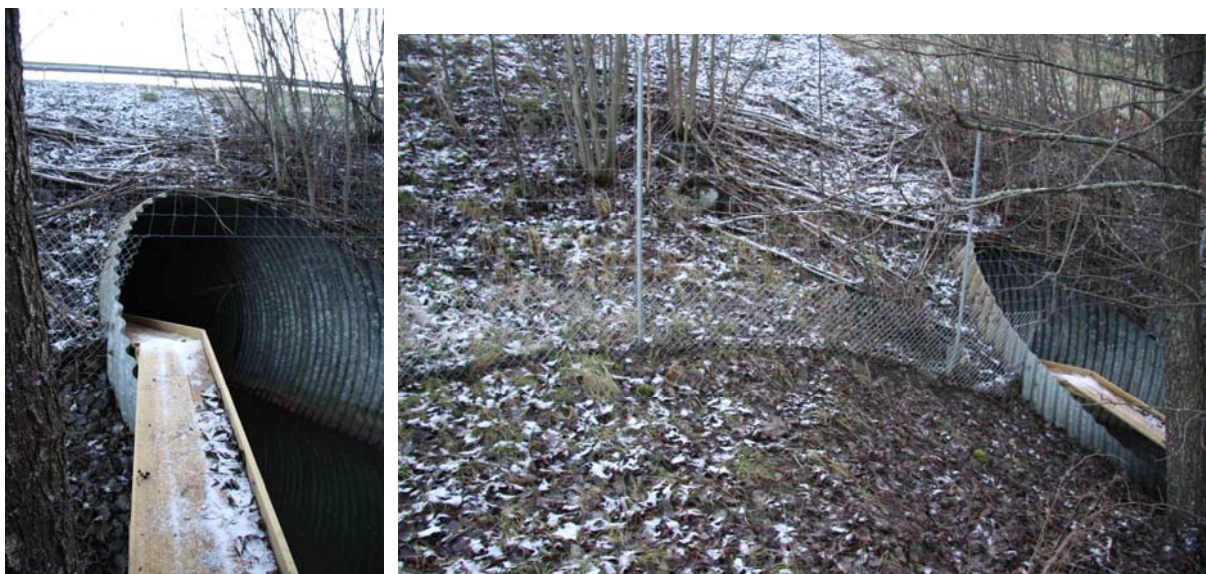
Figur 5. Trähyllan genom rörbron vid Osen (tv) och finmaskigt stängsel på befintligt viltstängsel (th). Foto: J Arrendal/MyraNatur.
