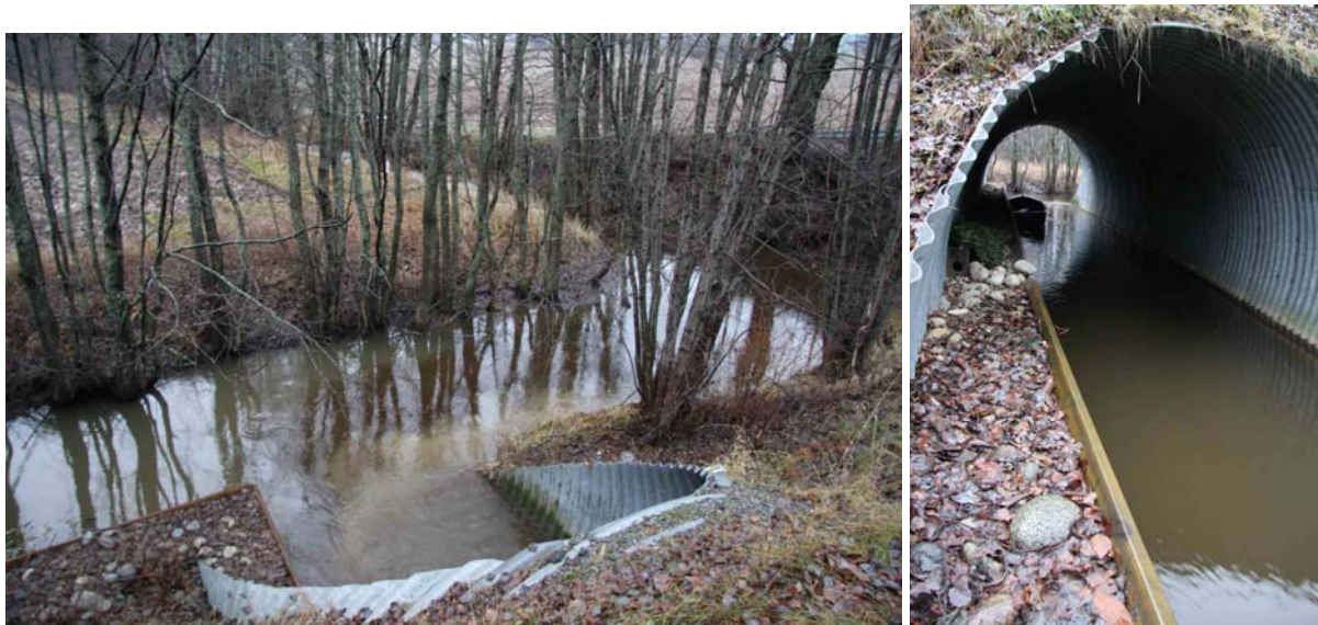
Figur 9. Två vattendrag flyter samman vid bron vid Rosenhill, hyllan syns i vänstra hörnet av bron (tv) och närbild på den fyllda hyllans material (th). Foto: J Arrendal/MyraNatur.
