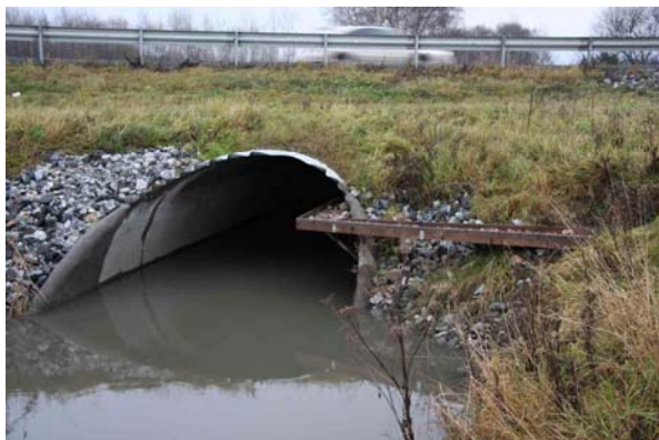
Figur 7. Fylld hylla vid Barkarby (tv) och närbild på hyllans stenfyllning (th). Foto: J Arrendal/MyraNatur.
